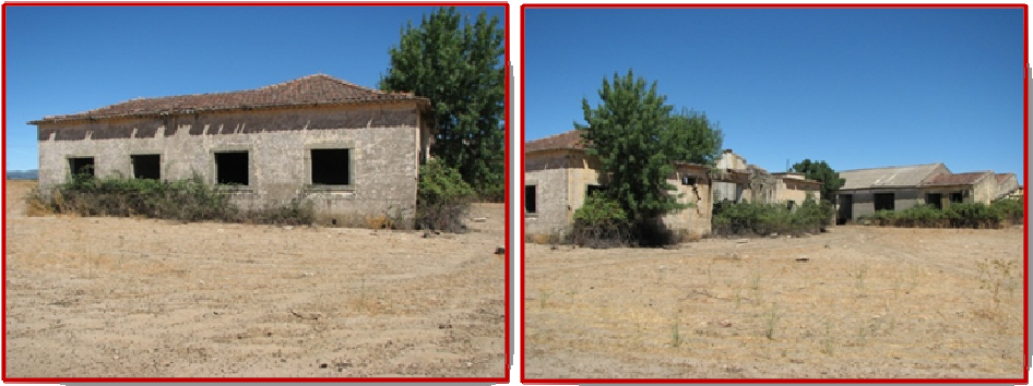
Figura 22 – Ruínas das instalações da Sociedade Mineira de Estanho da Lardosa, Lda.
