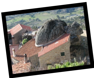
Figura 5 – Casas de habitação construídas em granito
