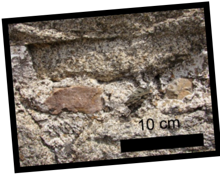
Figura 20 – Detalhe da muralha, reconstruída com granito, xisto e quartzito.
