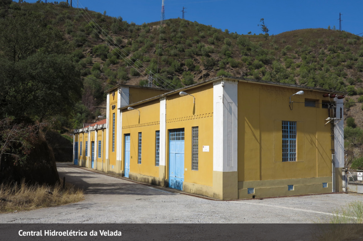
Central Hidroelétrica da Velada
